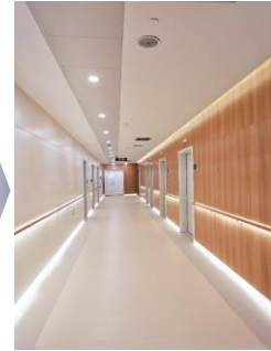
正直医院 院内施工例
